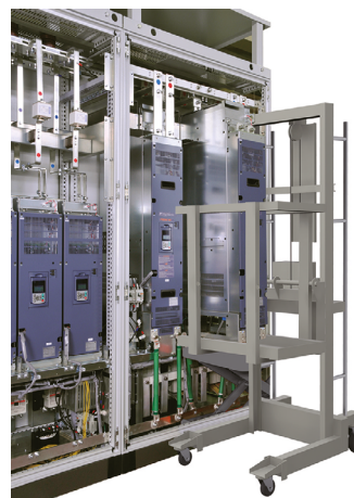
Пример использования подъемника
